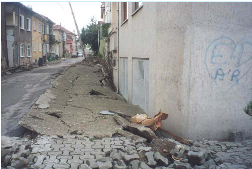
Figura 1.1-3 – Effetti dovuti a liquefazione (Izmit, Turchia, 1999).
