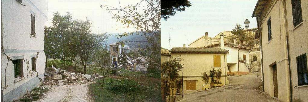
Figura 1.1-2 – Terremoto Umbria Marche, 1997. Differenza di danneggiamento in località vicine, dovute ad effetti locali. A sinistra Cesi Bassa (IX MCS), a destra Cesi Villa (VII MCS)
